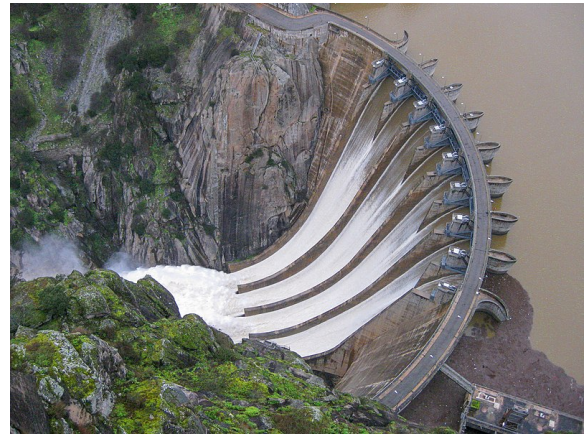
Presas de arco de Aldeadávila desembalsando debido a una crecida del río. Raíden32 , CC BY-SA 4.0 International , via Wikimedia Commons.
