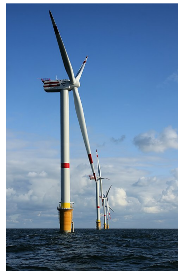
Aerogeneradores en Thornton Bank a 28km de la costa (off shore), en la parte belga del mar del norte. Hans Hillewaert , CC BY-SA 4.0 International , via Wikimedia Commons.
